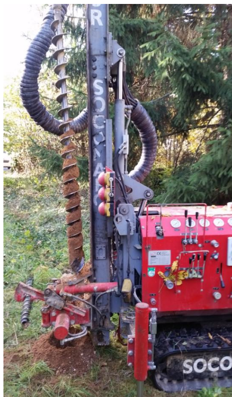
Figure 2 : Réalisation d'un sondage à la tarière mécanique
